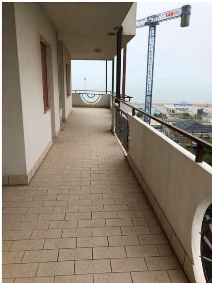
Foto 24 – balcone-terrazzo lato Sud- vista verso Est
