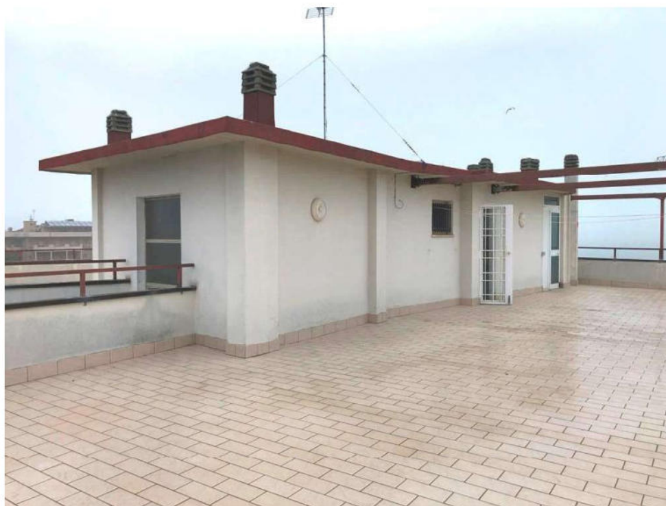
Foto 27 – lastrico solare – porta accesso scala interna
