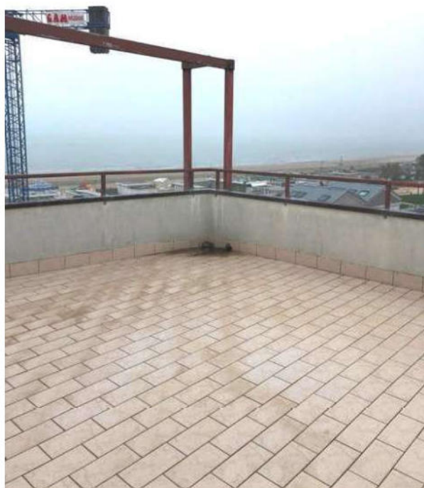
Foto 30 – lastrico solare vista verso Est
