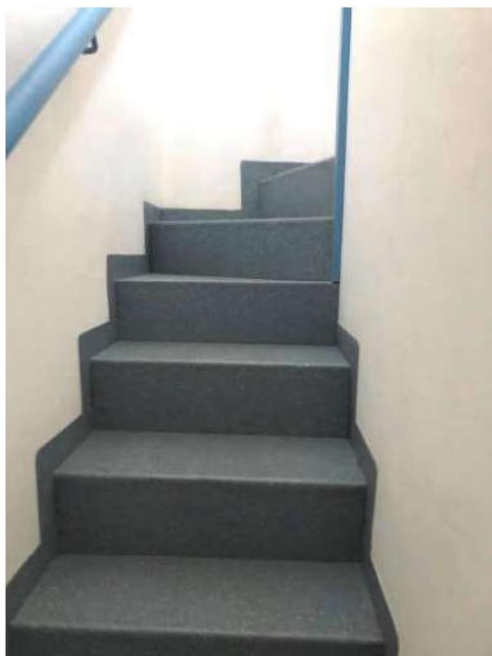
Foto 25 scala accesso lastrico solare
