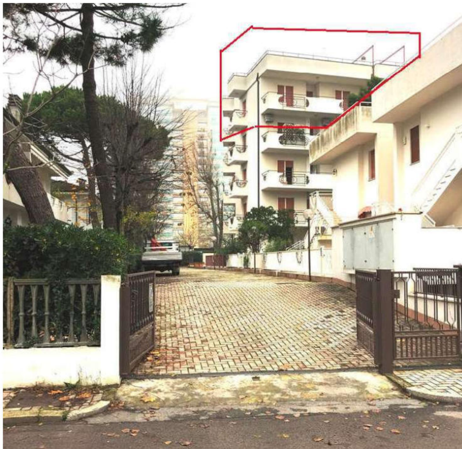
Foto 4-vista lato Sud- da ingresso carraio e pedonale da via Zara
